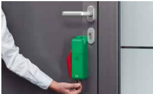
Über den Schließzylinder wird der Überwachungs- alarm ausgeschaltet. Der Überwachungshebel wird in der unteren Position arretiert. Die Tür kann nun beliebig über den Türdrücker geöffnet werden, ohne einen Alarm auszulösen.
